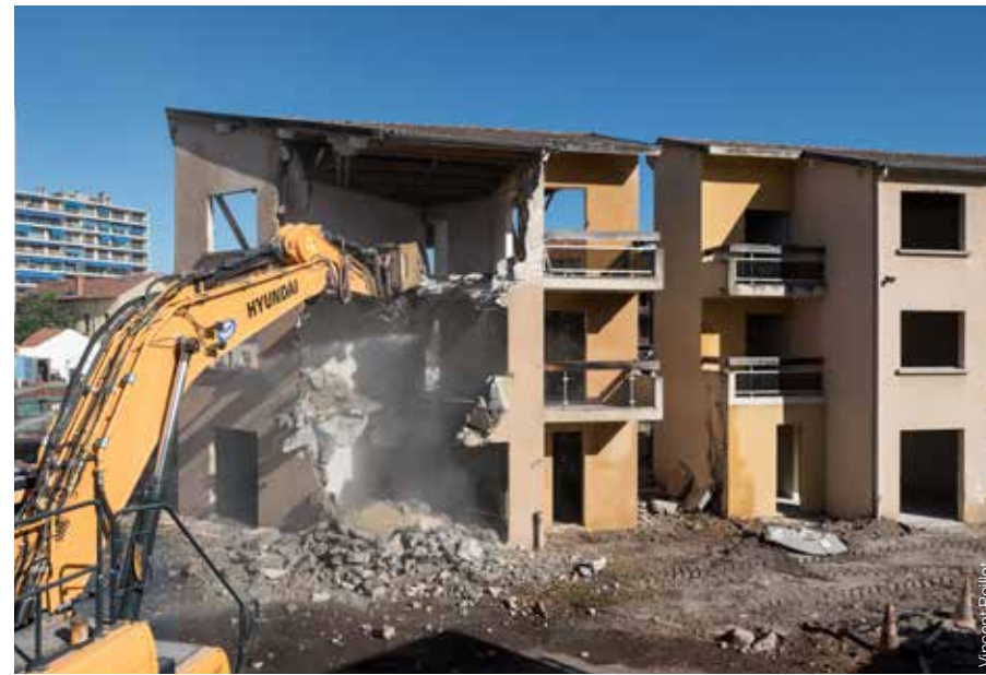
septembre 25 Le grand projet urbain et commercial Foch-Sully est entré dans sa phase de déconstruction avec notamment la démolition d'immeubles situés rues de Sully et Salengro. Ce sont 8 mois de travaux et 5000 m 2 de terrain concernés. Livraison prévue pour ce nouvel équipement en 2021.
